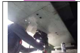
アトラーで削孔
