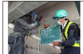
アトラーで削孔
