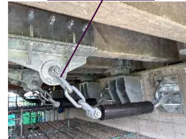
落橋防止構造
