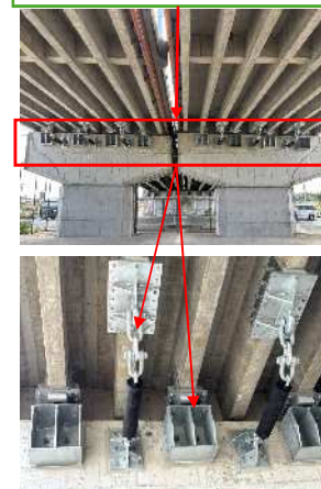
PC桁部せん断ストッパー、 落橋防止構造
