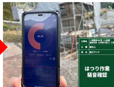
騒音を確認して作業を進めてます（66dBで基準はクリアしてます！！）
