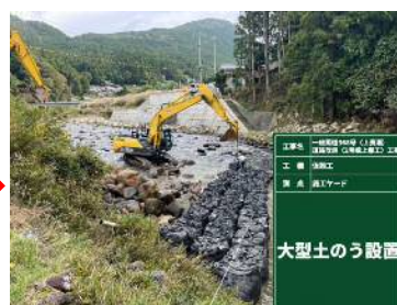
重機で川床を整理して土のうを設置（濁った水を出さないように注意します）
