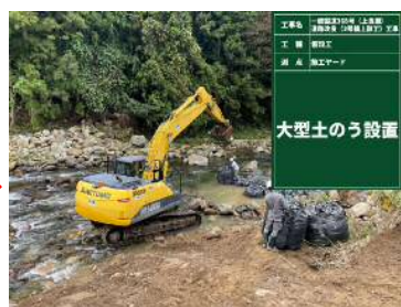
重機で川床を整理して土のうを設置（濁った水を出さないように注意します）
