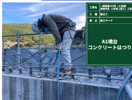
余分なコンクリートを斫ってます（大きな音があるのでカバーを付けて騒音対策してます）
