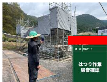
騒音を確認して作業を進めてます（66dBで基準はクリアしてます！！）
