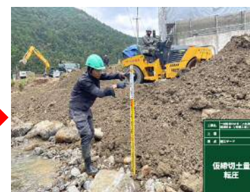
30CM毎に締固めを行い確認
