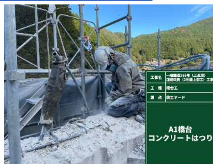
余分なコンクリートを斫ってます（大きな音があるのでカバーを付けて騒音対策してます）
