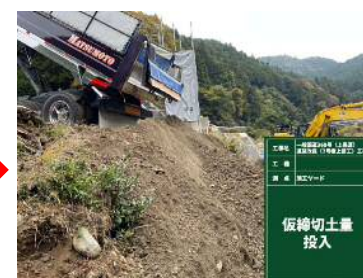
大型土のうで締切って土砂投入
