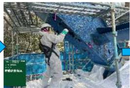
前日に専用の塗装剥離剤を塗布して翌日に塗膜を剥がす
