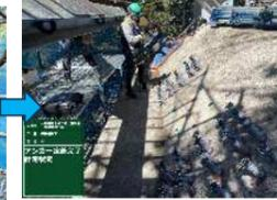
アンカーボルトの位置を確認して、ブラケットを製作する
