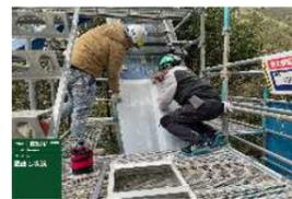
型紙を使用してボルトの位置をポンチで印をします
