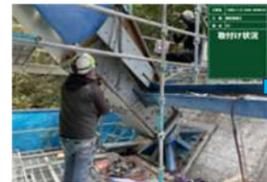
チェーンブロックを使用しながら1枚ずつ取付をする。取付終わり次第高力ボルトで締付ける
