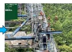
人力で移動後、クレーンで撤去材を吊り上げる
