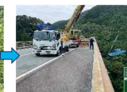
P1側は車両が橋脚の近くまで行けない為橋の上からクレーンを使用している荷下ろし
