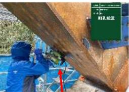
ボルト削孔機械（アトラー）を使用して、印をした所に合わせて削孔する。
