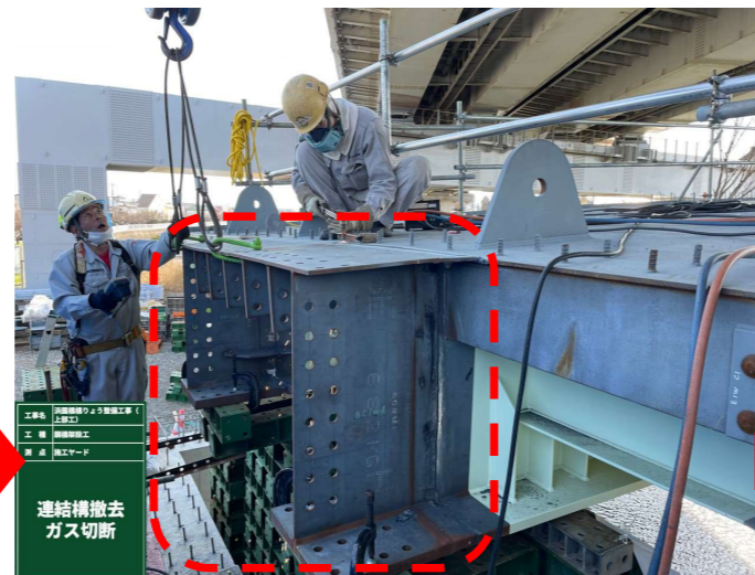
本体と一体化されている部分をガス切断
