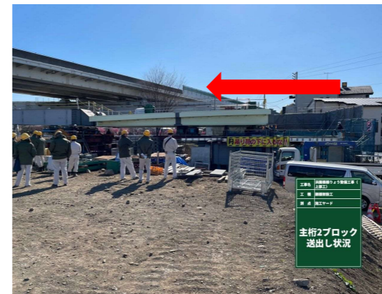
工事名 浜園橋様より陸橋工事(上部工) 工種 鋼橋架設工 測点 施工ヤード 主桁2ブロック 送出し状況
