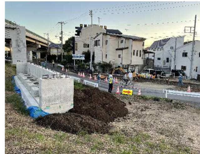
切り直し作業：A2橋台側背面道路に作業構台を設置するため
