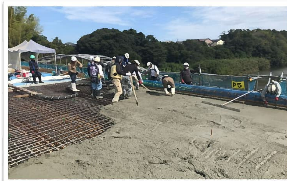
コンクリート打設
