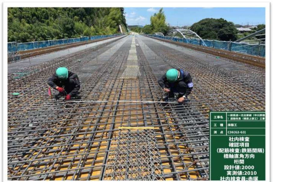
社内型枠・配筋検査
