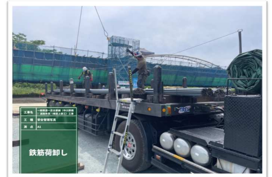
鉄筋荷卸し
