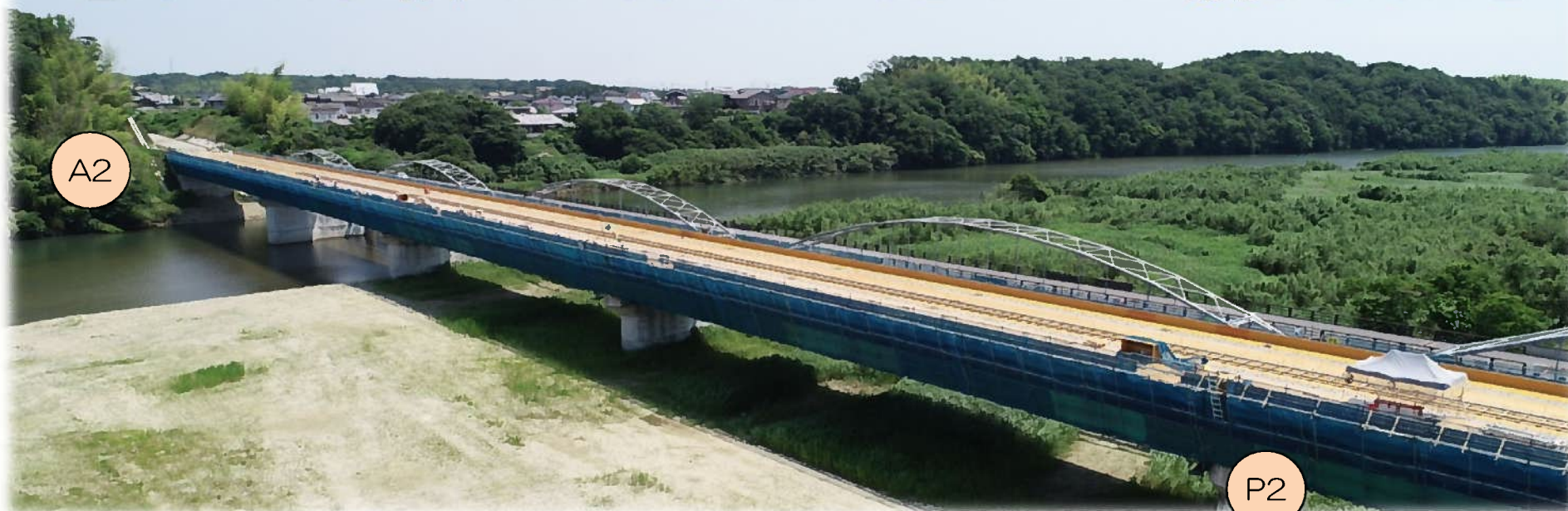
型枠組立完了
