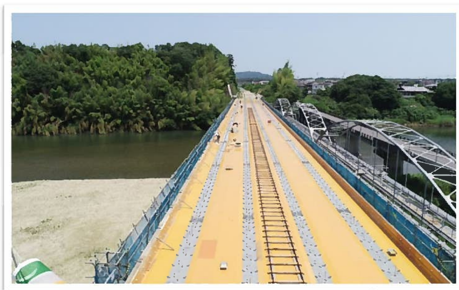
型枠組立完了
