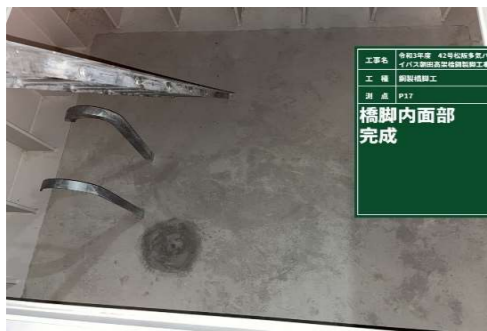
中詰めコンクリート
