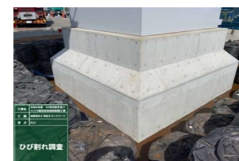
根巻コンクリート
