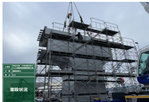
橋脚架設、足場組立
