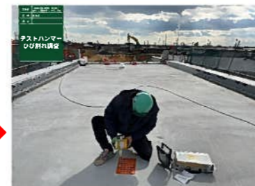
各種確認・試験を実施 (強度確認・ひび割れ確認)
