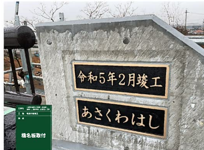
親柱・橋名板設置
