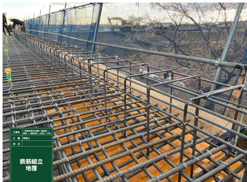
鉄筋組立完成
