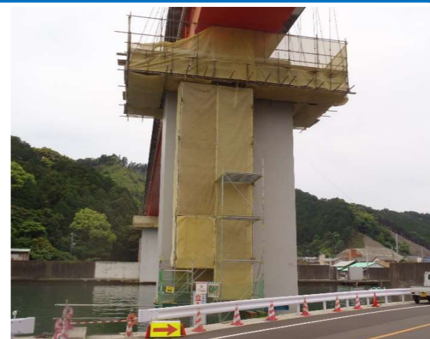
仮設吊足場及び昇降施設設置完了
