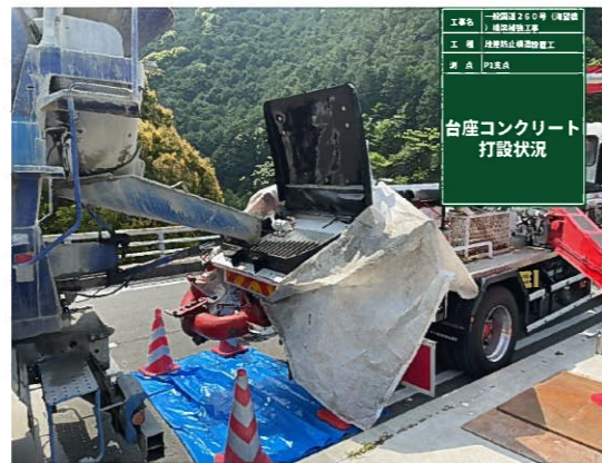
P1支点：道路を規制して橋面より打設
