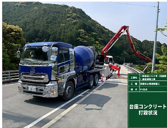
P1支点：道路を規制して橋面より打設
