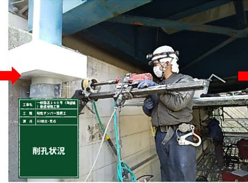
削孔ドリルで穴あけ
