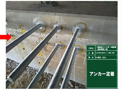
アンカーボルトを差込み 接着剤で固定
