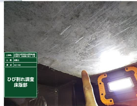
ひび割れ調査
